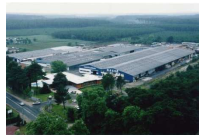
Vue aérienne du site DASSE de Castets
