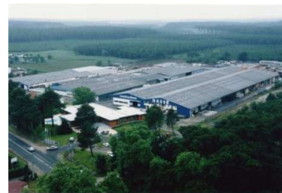
Vue aérienne du site DASSE de Castets
